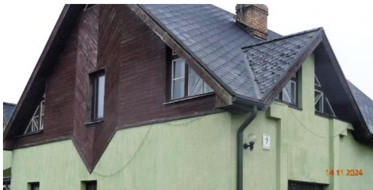
Skats uz Ēkas 2.stāvu
